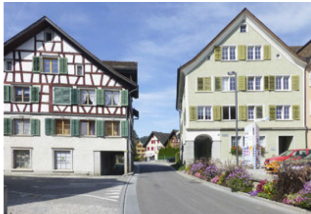
Referenzbeispiel: Neugestaltung der Dorfstrasse und des Kirchplatzes in Thal SG
